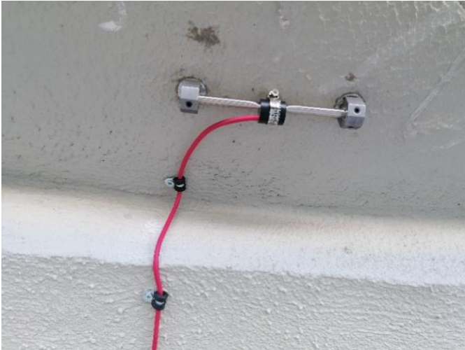
Corde vibranti in soletta e alla base di appoggio.
